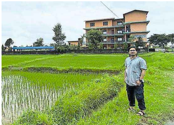
Das Gebäude in Tilottama nahe der Stadt Butwal steht bereits. Bald wollen Jeanine Eberle (oben links und unten rechts) und ihr Freund Amit Bidhyarhi (unten links) darin ihre Schule eröffnen. Aktuell treffen sie die letzten Vorbereitungen vor der Eröffnung. Bilder: zvg
